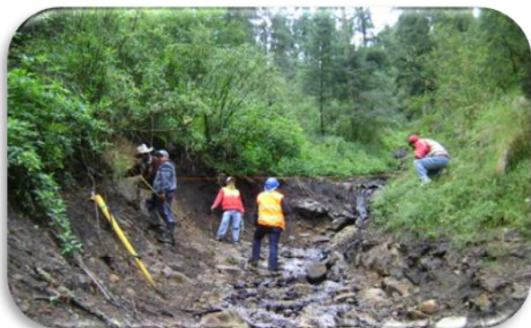
Foto 3 y 4. Construcción de presa de gaviones para detener la erosión hídrica en cauce dentro de la Reserva de la Biósfera “Mariposa Monarca”. Felipe de Jesús Martínez (2011)
