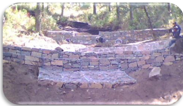
Foto 3 y 4. Construcción de presa de gaviones para detener la erosión hídrica en cauce dentro de la Reserva de la Biósfera “Mariposa Monarca”. Felipe de Jesús Martínez (2011)
