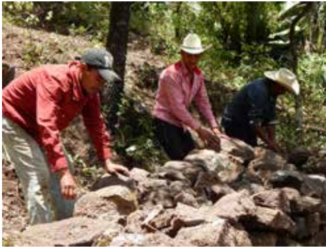
Estacadas con piedra acomodada, Puerto de Palo Gordo, Ciudad Fernández, S. L. P.
