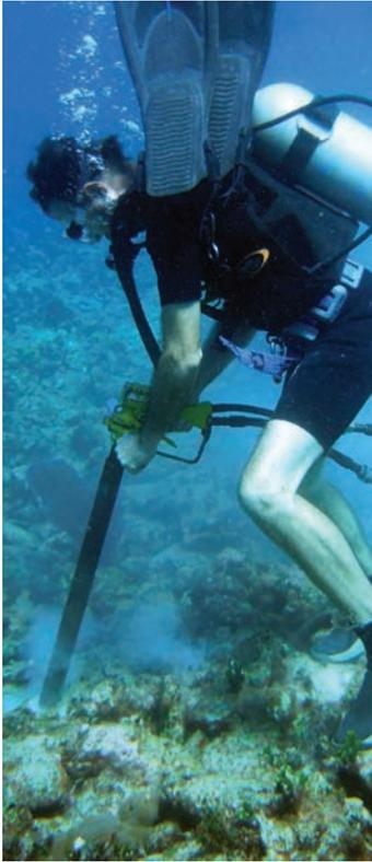
Perforación y colocación de anclajes para reforzar el sistema de señalización del Parque Nacional tendiente a mitigar los daños al arrecife, en el año 2011.
